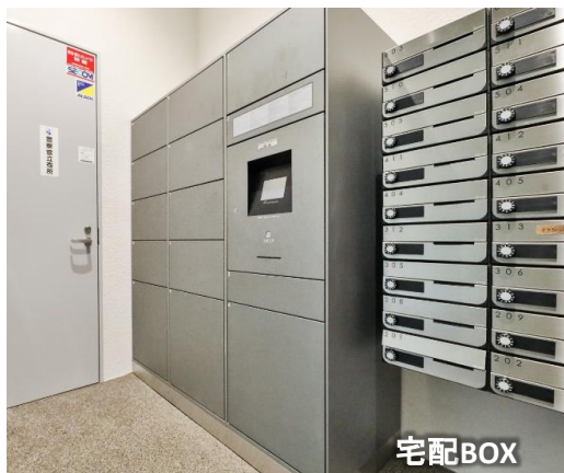
エントランス／オートロック
